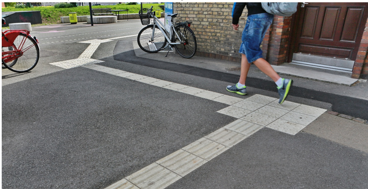
Eksempel på en tydelig ledelinje, som bliver en grafisk del af projekt ideen. Hvis den kunstige ledelinje benyttes skal der, j.fr. de nye vejregler, være minimum 3 følbare ribber
